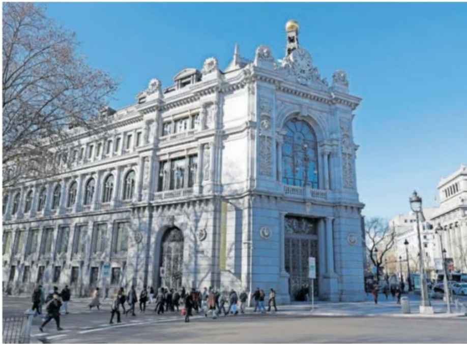
Fachada principal del Banco de España, en Madrid. PABLO MONGE
